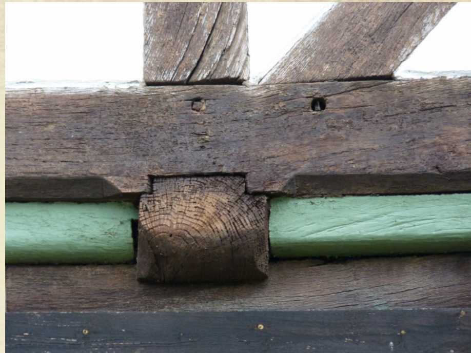
Abbildung 4: Deckenbalkenzone des Hauses Bonafurther Str. 120; die Füllhölzer sind hier grün angestrichen
