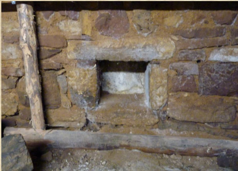
Abbildung 2: Mauernische im Keller
