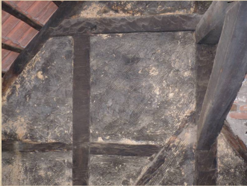
Abbildung 3: Gefache im Dachgeschoss
